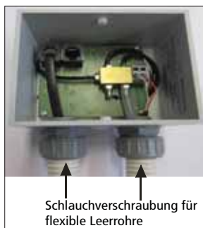
Abb. 3.3 Kabel- und Schlauchdurchführung im UP-Gehäuse
