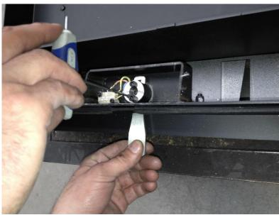
13. Madenschrauben kann zum fixieren des Hebels genutzt werden.
