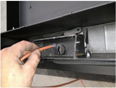
7. Das Türkontaktkabeldurch denLeitungsdurchgang legen.
