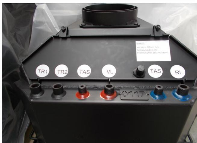
Bei der Montage des Powertauschers ist darauf zu achten, dass alle Verschraubungen der Rohrleitungen für Wartungen zugänglich sind und so angeordnet, dass der Wartungsdeckel problemlos geöffnet werden kann.
